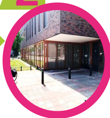
Woonvoorziening Maassluis ASVZ Foto: Sari Bravenboer
